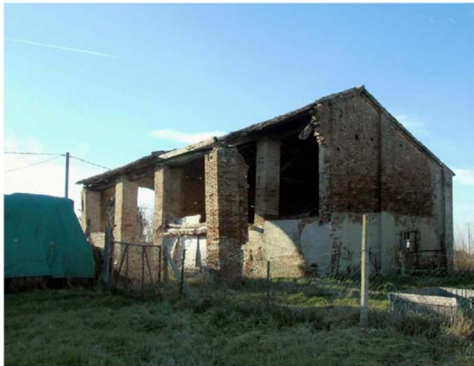
Oggetto Fabbricato ad uso ex stalla-fienile (2): fronti sud-est e sud-ovest
